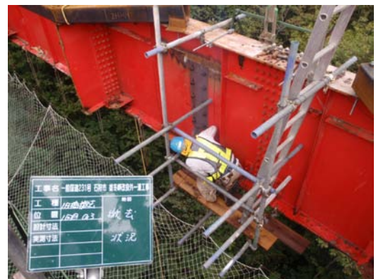
図-4 外桁ブロック割り
