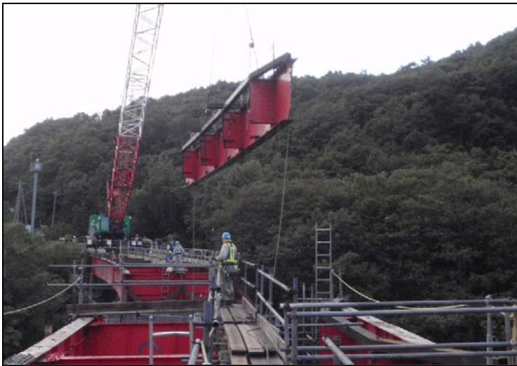
図-4 G3桁中央径間撤去状況
