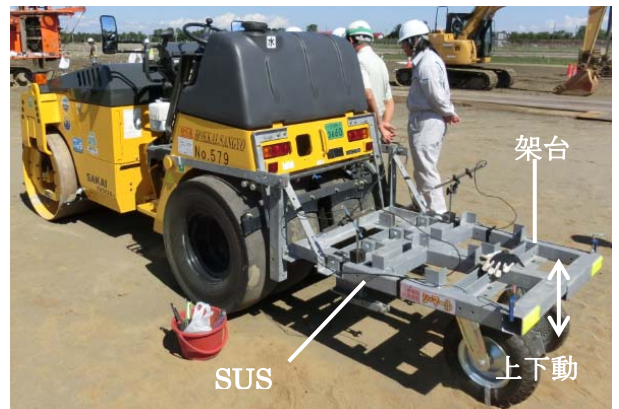
図-1 締め固め測定機
