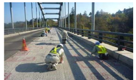
写真-1 打音試験状況
