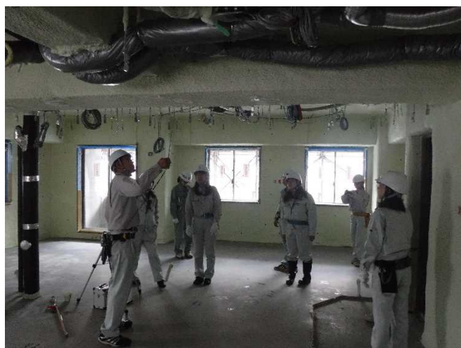
《 現場見学 断熱工事 》
