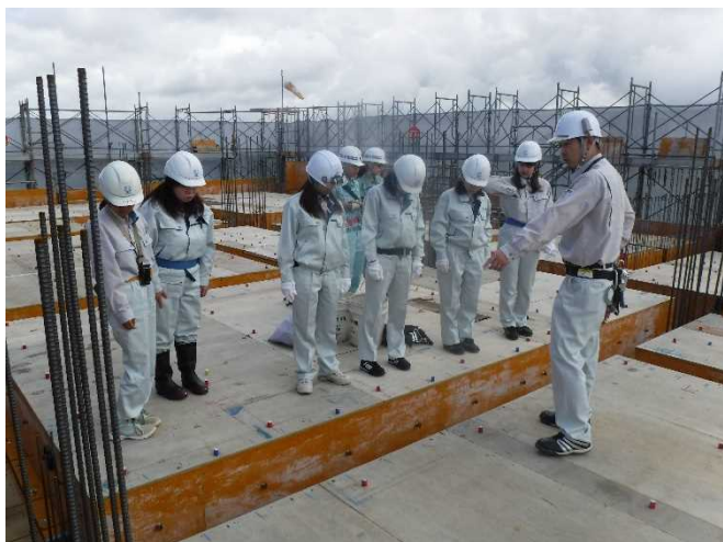
《 現場見学 型枠工事 》
